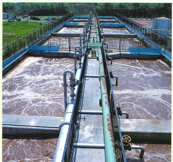
河川、湖沼の水質保全の面から加工排水の汚濁負荷を除く処理として、当工場では生物処理方式を基本に考えています。
